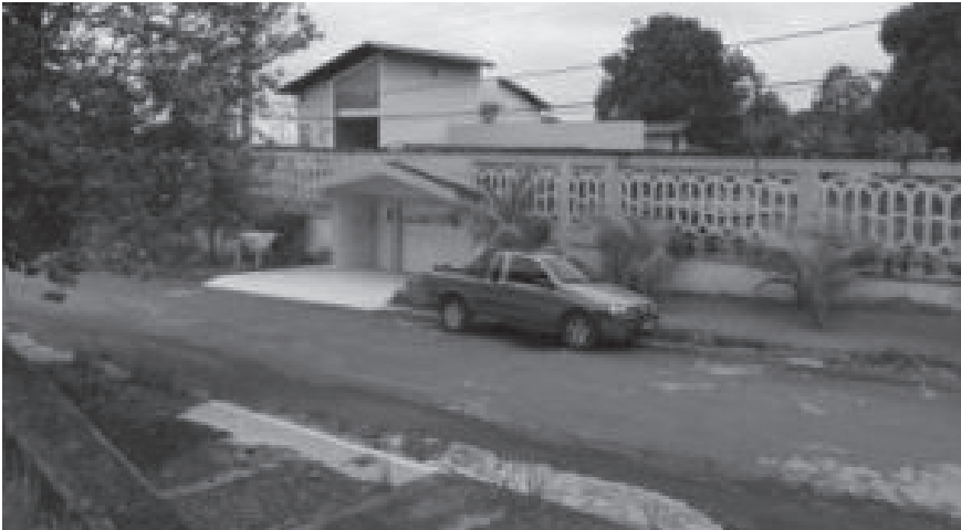
Figura 3 – Foto de residência antes da reforma.
